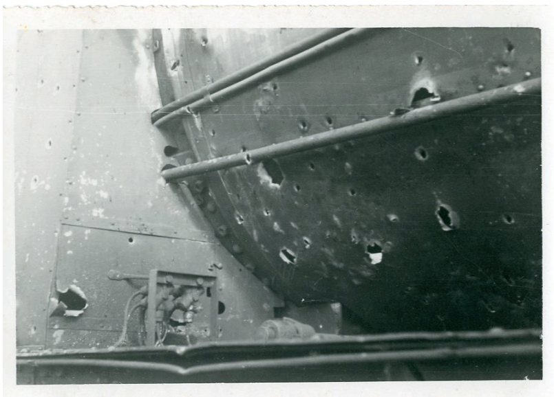
Průstřely kotle parní lokomotivy (Muzeum Chodska v Domažlicích).
